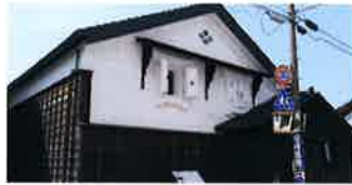
百年の蔵 (旧十二銀行 米倉) 魚津の米騒動のシンボルとされる大正生まれの蔵。県内現存する米騒動関連、唯一の建築物。今も現役の倉庫。
